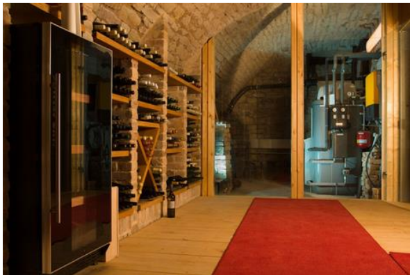
Gewölbekeller mit Technikraum
