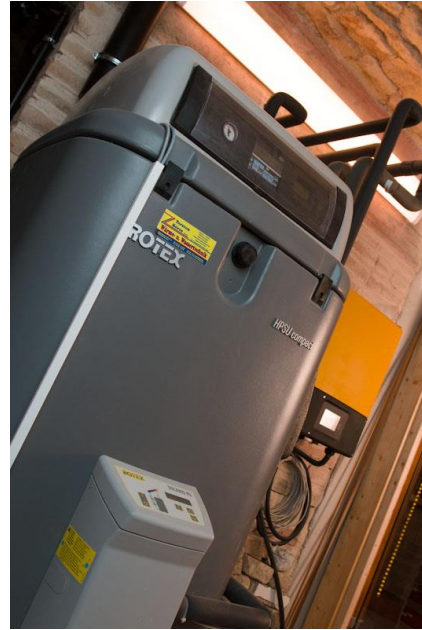
Der Warmwasserspeicher
